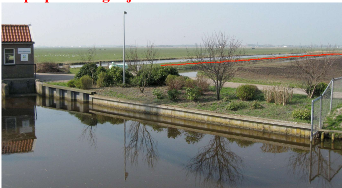
13. Kijkpunt Limmerdam (rode lijn op bovenstaande foto)
